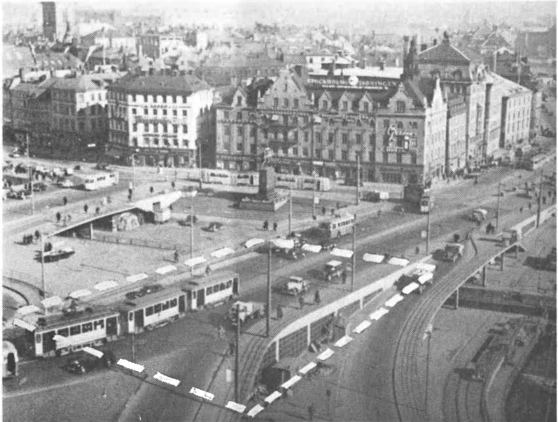
Norra järngraven vid Slussen från markytan, en av Stockholms kanske ur miljösynpunkt sämsta arbetsplatser. Där hade man börjat bedriva en luftvärnsmekanikerutbildning redan år 1941, alltså året innan tygförvaltningsskolan började sin verksamhet.
